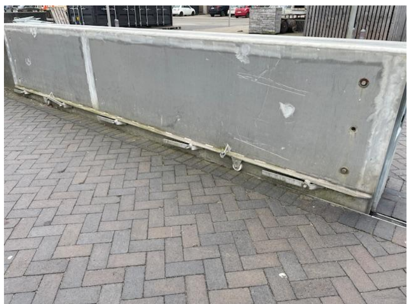
Figur 3.9: Viser en rulleport monteret på en betonmur, som kan skydes i og lukke åbningen i tilfælde af varslet højvande.
