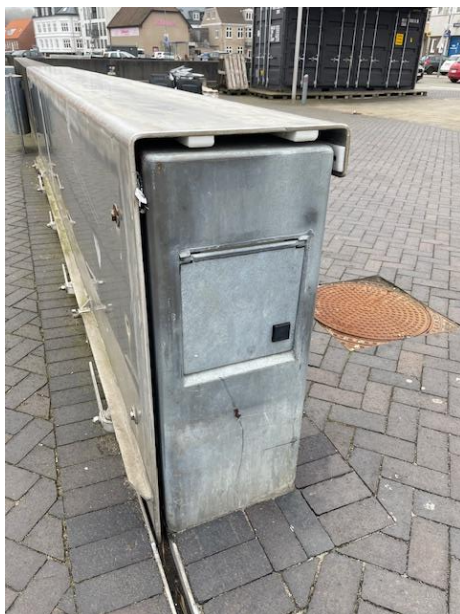
Figur 3.9: Viser en rulleport monteret på en betonmur, som kan skydes i og lukke åbningen i tilfælde af varslet højvande.
