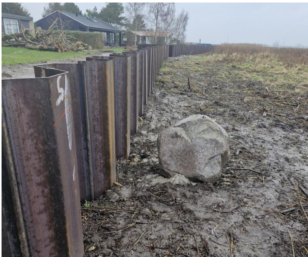
Figur 3.7: Viser hvordan en spunsvæg kan se ud, når den er etableret. Kilde: NIRAS' projekt i Hyllingeriis 2024.
