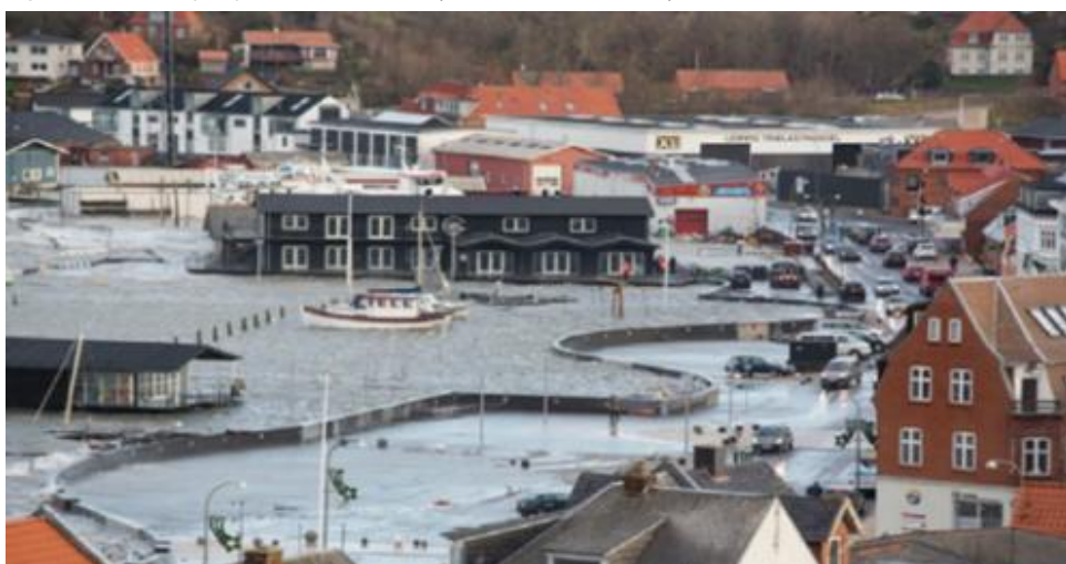
Figur 3.6: Viser en højvandsmur i Lemvig under en stormflodshændelse, hvor der er højere vandstand på havsiden af muren end terrænet er på landsiden af muren. (Kystdirektoratet, u.d.).
