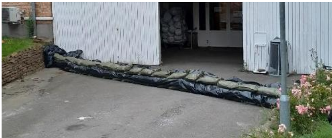
Figur 3.10: Viser sandsække på tværs af indkørsel som kan etableres i tilfælde af højvande.
